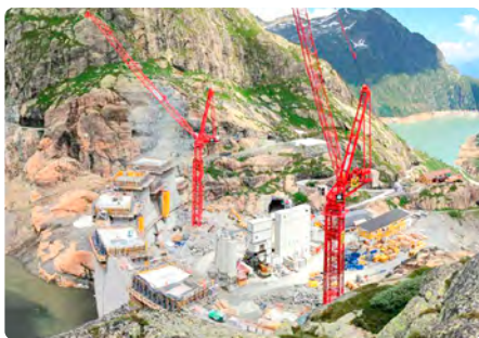
Fot. 10. Podwyższanie zapory Vieux-Emosson, lipiec 2013
