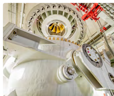
Fot. 15. Instalacja zaworu kulowego pod turbiną
