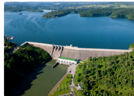
Fot. 5. Widok zapory Solina za zbiornikiem górnym, elektrownią i zbiornikiem dolnym Myczkowce
