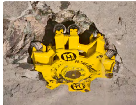
Fot. 7. Wiertnica wznosząca wykonująca odwierty dla potrzeb budowy szybów ciśnieniowych
