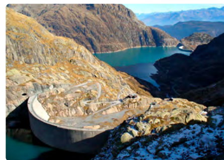
Fot. 2. Widok istniejącego systemu energetycznego z zapory Vieux-Emosson
