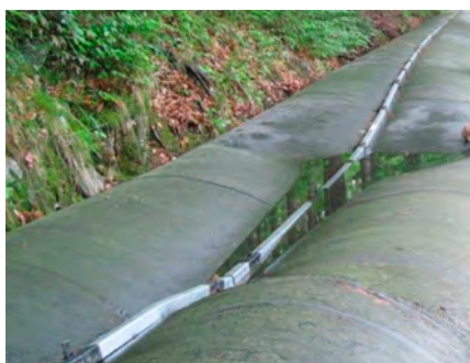
Rys. 8. Przypadek nr 2: przebieg zmian ciśnienia w rurociągu podczas testów rozruchowych oraz miejsca zniszczenia powłoki rurociągu wywołanymi uderzeniem hydraulicznym
