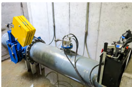
Fot. 3. Przykład instalacji przepustnicy uruchamianej czujnikiem nadmiernej prędkości
