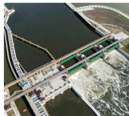
Fot. 8. Stopień wodny Malczyce – 3-przęsłowy jaz, elektrownia wodna, służa żeglugowa
