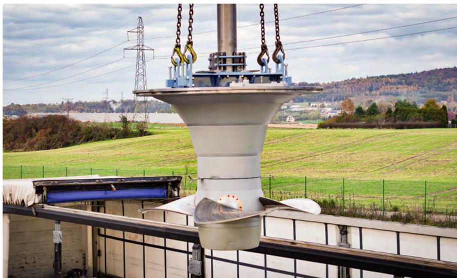
Fot. 2. Transport wirnika turbiny
