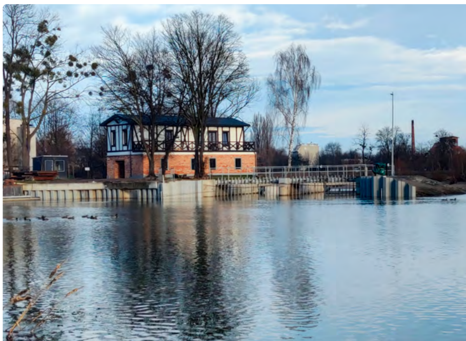
Fot. 5. Budynek dawnego klubu żeglarskiego zaadaptowany na potrzeby sterowni przyszłej MEW, na pierwszym planie widoczne kanały wlotowe do hydrozespołów
