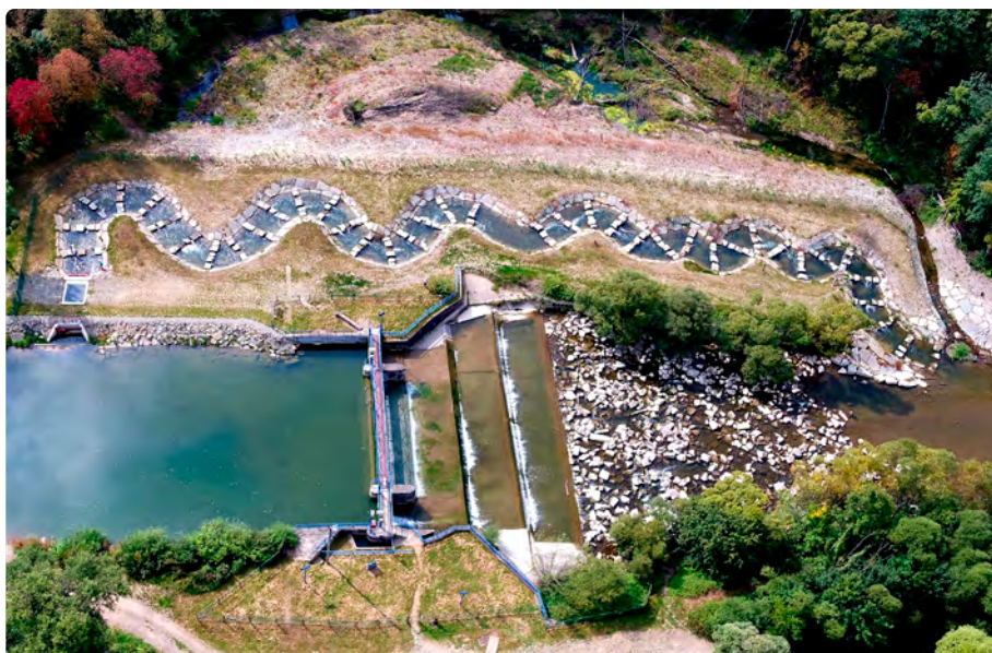
Fot. 11. Kanał obejścia jazu piętrzącego wodę na potrzeby ujęcia wodociągowego. Miejscowość Szczepańcowa, rzeka Jasiołka – km 27+960
