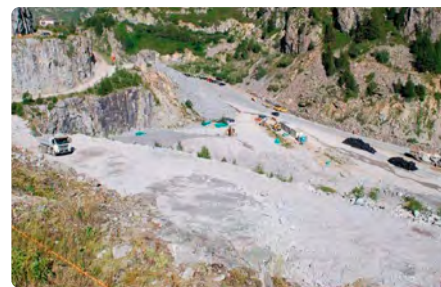
Fot. 12. Zасыpywanie urobkiem istniejącego kamieniołomu La Gueulaz (mógł on pomieścić 350,000 m 3 urobku)
