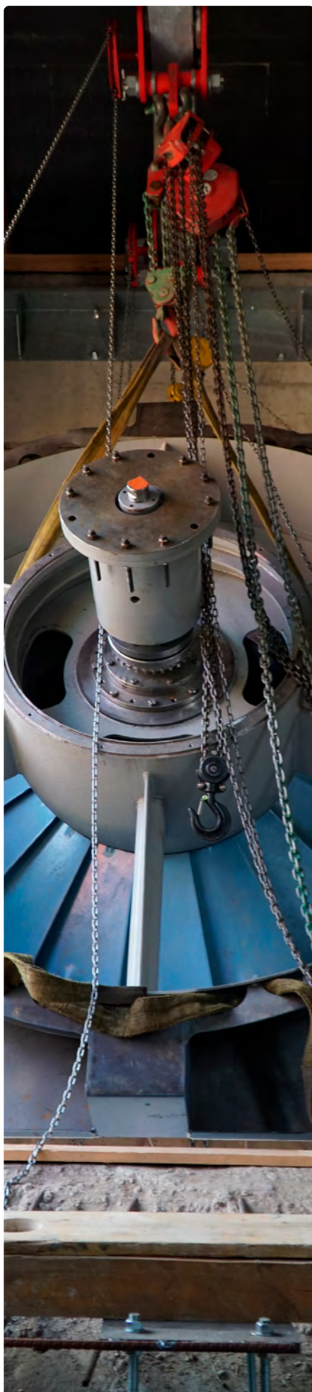
Fot. 6. Montaż nowej turbiny w budynku elektrowni
