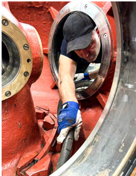
Fot. 2. Ręczne oczyszczanie wnętrza piasty wirnika, optywka turbiny przed rozpoczęciem remontu
