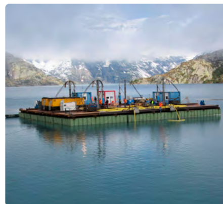
Fot. 9. Spławianie konstrukcji ujęcia wody dolnej przez zbiornik Emosson
