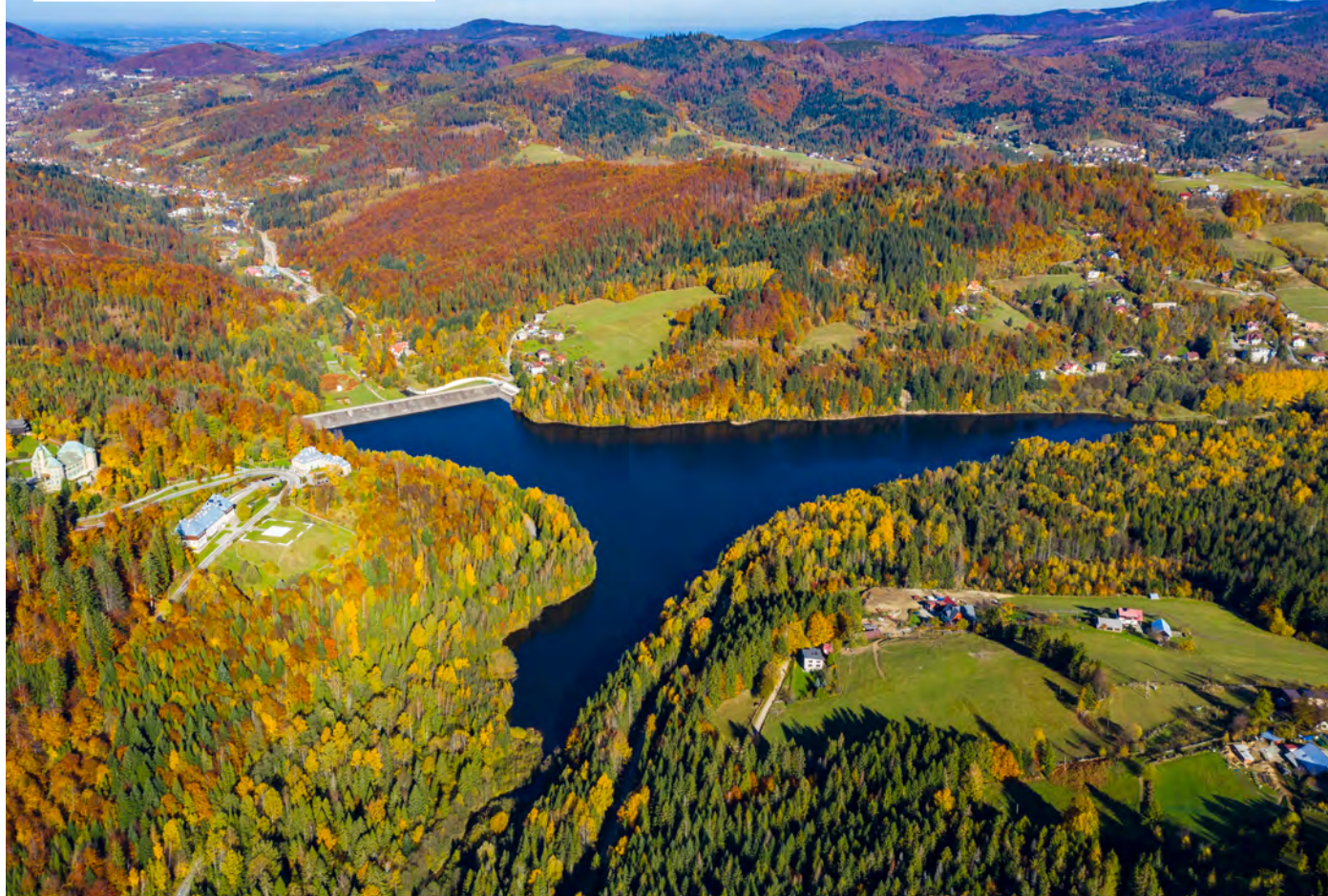
FOT. ZBIORNIK WISŁA-CZARNE PO MODERNIZACJI
