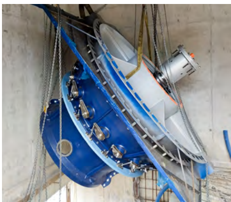
Fot. 3. Od lewej: montaż warsztatowy wirnika turbiny, montaż in situ komory turbiny z wirnikiem, wpasowanie turbiny do rury ssącej
