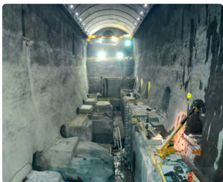
Fot. 4. W pełni wydrążona główna komora elektrowni, lato 2014
