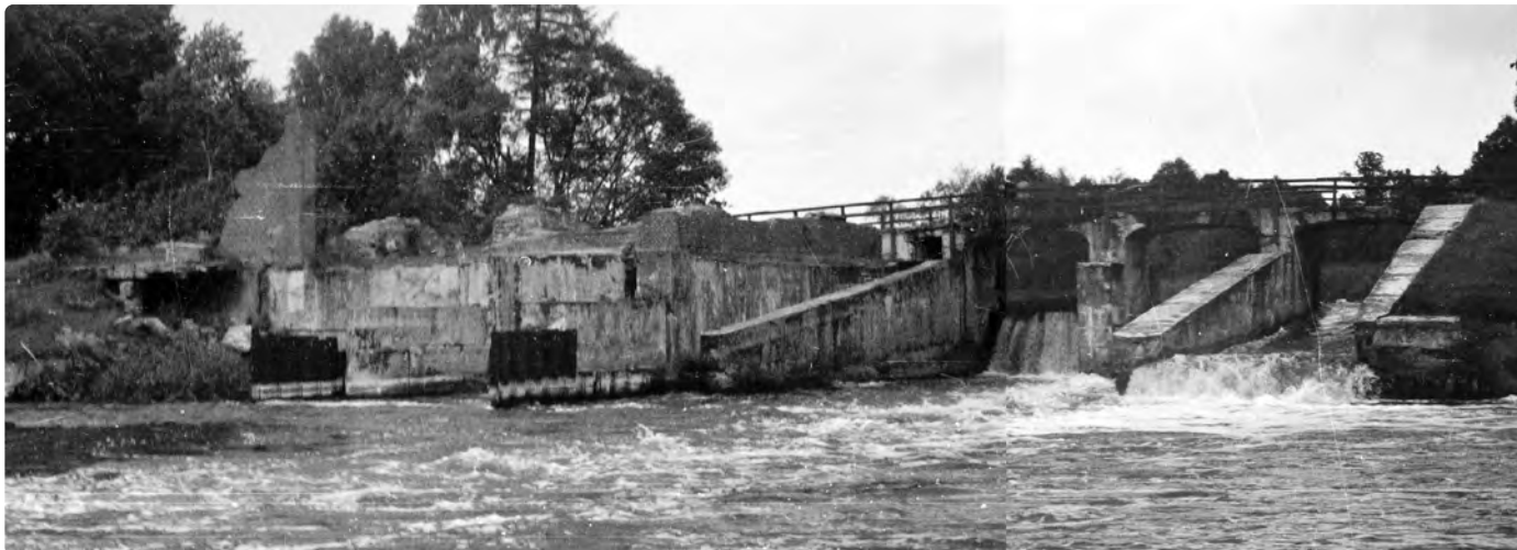
Fot. 3. Widok na jaz i ruiny budynku MEW (lata 80. XX w.)
