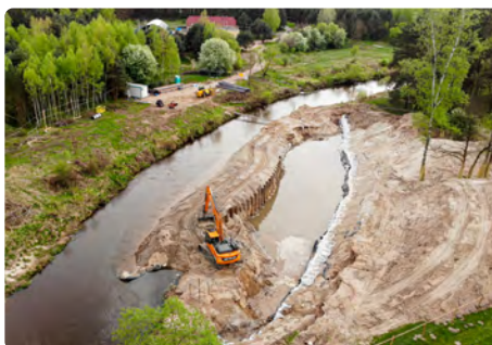
Fot. 2. Od lewej: rozpoczęcie robót ziemnych, wbijanie ścianek szczelnych, komora napływowa do MEW
