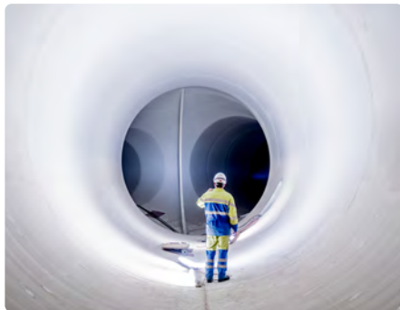
Fot. 6. Trójnik rozwidlający z redukcją średnicy z 5,5 m do 3,2 m
