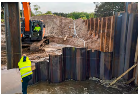
Fot. 2. Od lewej: rozpoczęcie robót ziemnych, wbijanie ścianek szczelnych, komora napływowa do MEW
