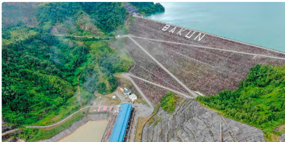
Fot. 1. Zapora Bakun oraz elektrownia wodna w Sarawaku w Malezji
