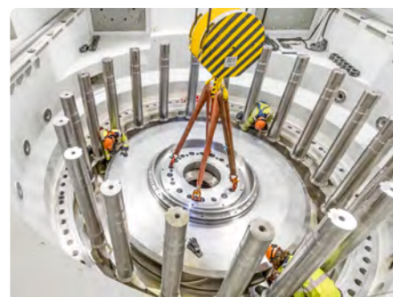
Fot. 14. Montaż wirnika turbiny
