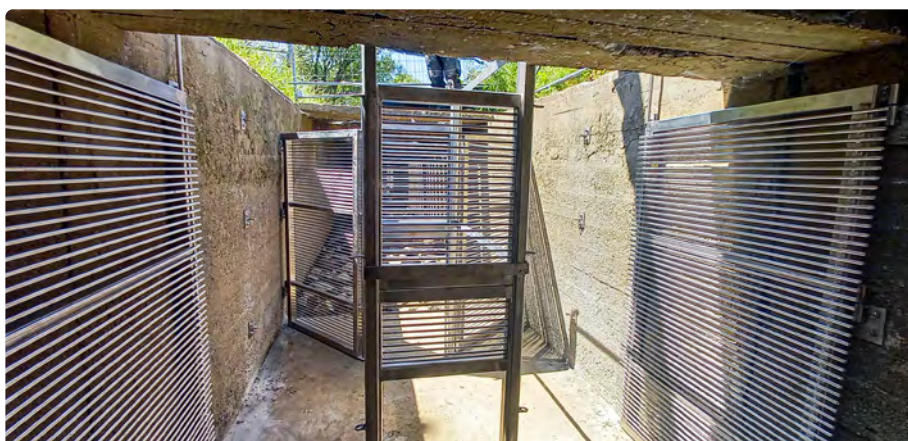
Fot. 3. Widok na sekcję monitoringową przepławki w m. Broszkowice na rzece Sole. Zmodernizowana przepławka jest dostosowana do wyposażania jej w przyszłości w instalację podwodnego monitoringu video
