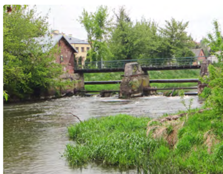
Fot. 2. Jaz na rz. Orzyca przed i po realizacji inwestycji
