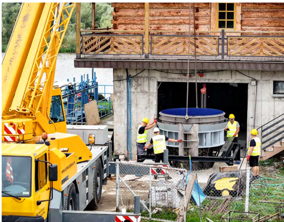
Fot. 3. Montaż komory turbiny Kaplana
