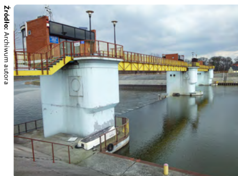
Fot. 5. Stopień wodny Koźle na rz. Odrze – jaz 2-przęsłowy i służa żeglugowa
