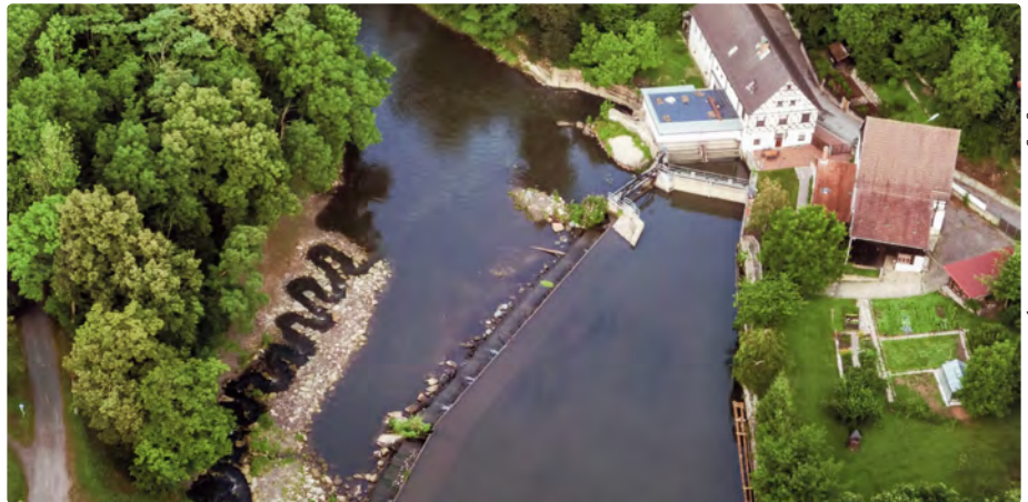
Fot. Mała elektrownia wodna Heinzenmühle, Górná Frankonia, Niemcy
