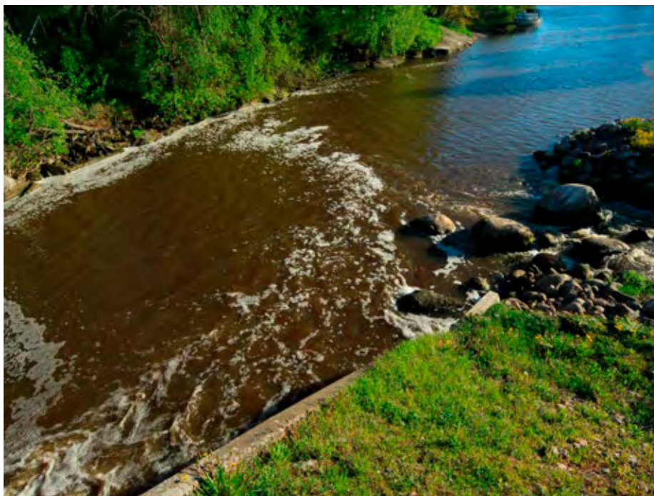
Fot. Wejście do przepławki naturalnej z dobrze widocznym prądem wabiącym
