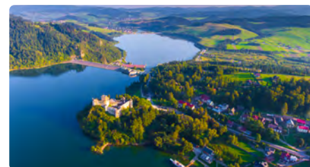
Fot. 7. Widok zbiornika górnego i wyrównawczego zapory Czorsztyn-Niedzica.
