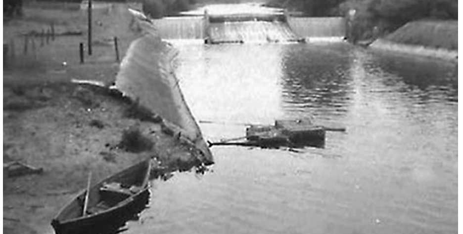
MEW Rościno – stan z lat 50. ubiegłego stulecia.
