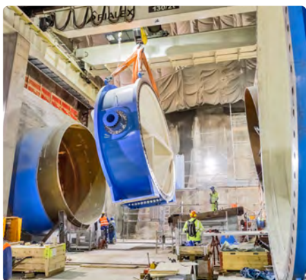
Fot. 5. Montaż przepustnicy motylowej na górnym odcinku toru wodnego pomiędzy zbiornikiem Vieux Emosson i szybem pionowym
