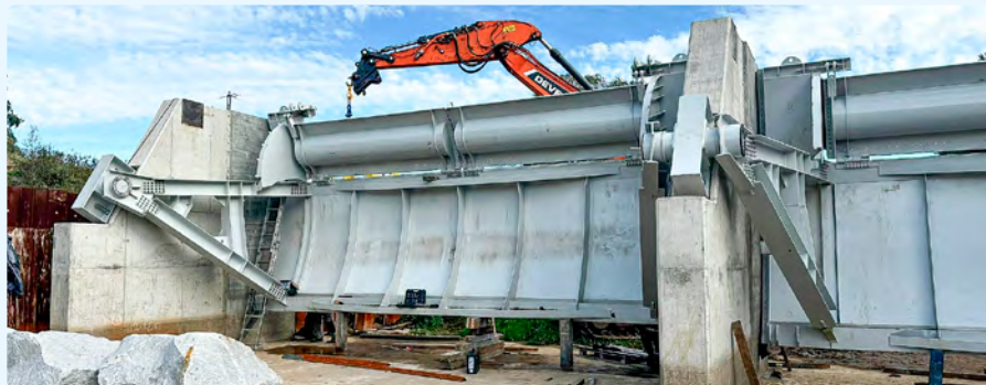
Fot. 5. Zamknięcia segmentowo-klapowe jazu
