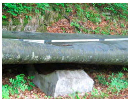
Rys. 8. Przypadek nr 2: przebieg zmian ciśnienia w rurociągu podczas testów rozruchowych oraz miejsca zniszczenia powłoki rurociągu wywołanymi uderzeniem hydraulicznym
