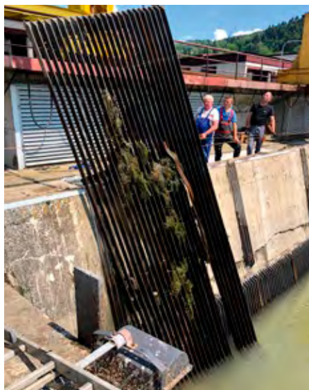
Fot. Wydobywanie uszkodzonej kraty
