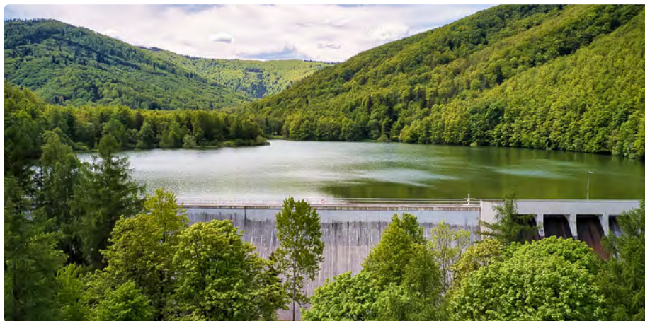
Fot. 1. Widok zapory wodnej i zbiornika retencyjnego w Wapienicy
