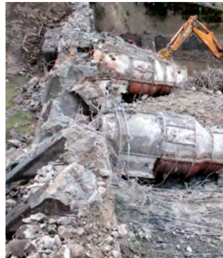
MEW Rościno – prace demontażowe. 2013 r.
