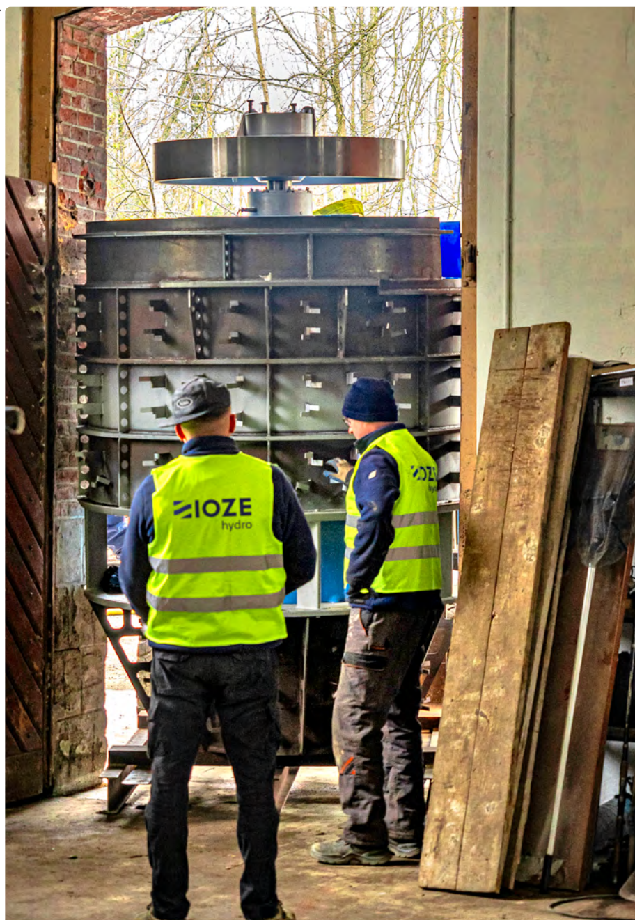
Fot. 3. Transport turbin do wnętrza młyna
