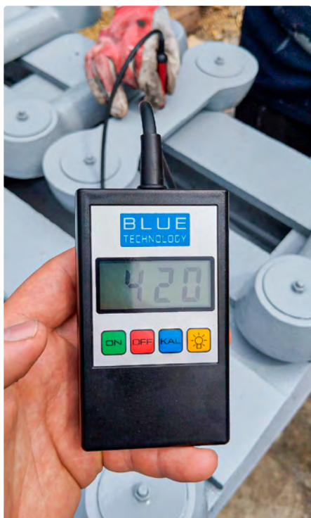
Fot. 7. Pomiar powłoki antykorozyjnej w procesie nakładania warstw
