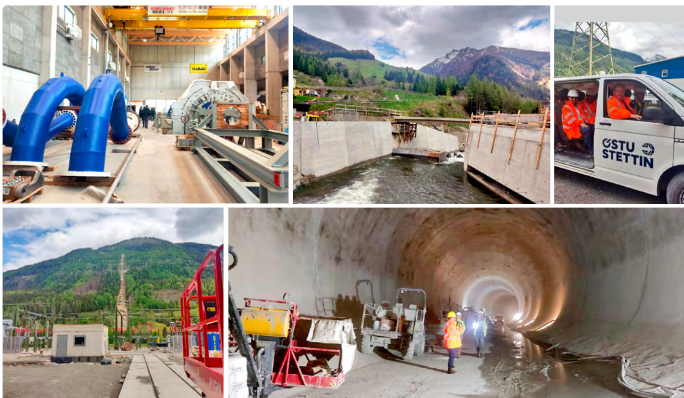
Fot. 4. (Od lewej): Hala maszyn elektrowni wodnej Obervellach II – ujęcie wody, uczestnicy gotowi do zwiedzania budowy, rozdzielnia elektrowni i rurociąg (w tle), kawerna zbiornika retencyjnego
