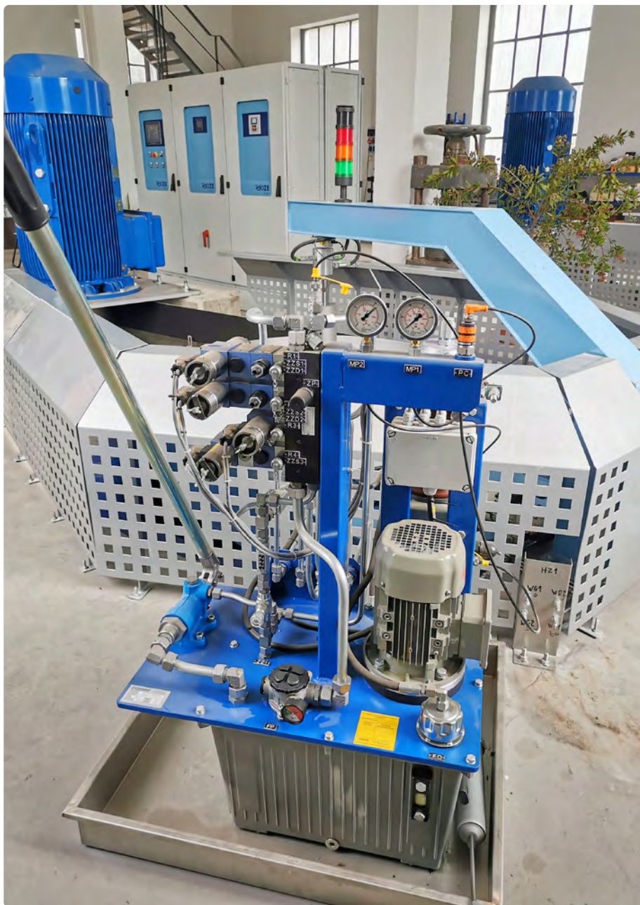
Fot. 5. Wnętrze hali maszyn po modernizacji
