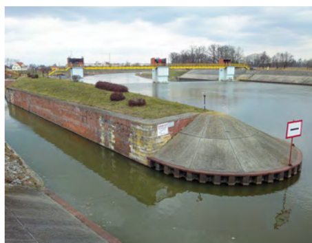
Fot. 5. Stopień wodny Koźle na rz. Odrze – jaz 2-przęsłowy i służa żeglugowa
