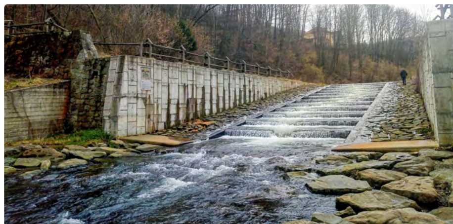
Fot. 3. Bystrze w postaci kaskady progów tworzących przepławkę dla ryb (Potok Trzebuńka, Stróża)
