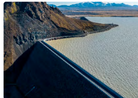
Fot. 2. Zbiornik wodny Hálslón i zapora Kárahnjúkar w Islandii
