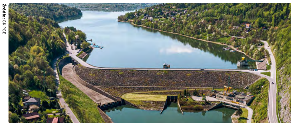
Fot. 6. Tresna – zapora ziemno-narzutowa z odrębnymi spustami dennymi i przelewem powierzchniowym stokowym
