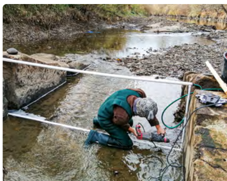
Fot. 9. Montaż anteny w szczeliny migracyjnej w m. Gorlice, rz. Ropa
