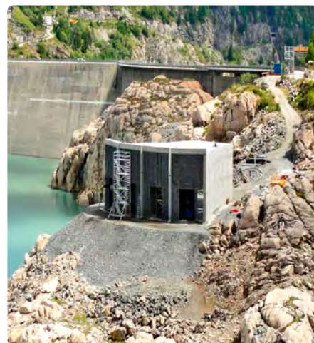
Fot. 8. Budowa ujęcia wody dolnej
