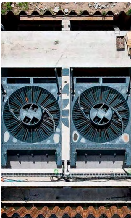
Fot. 2. Dwie turbiny VLH w trakcie montażu
