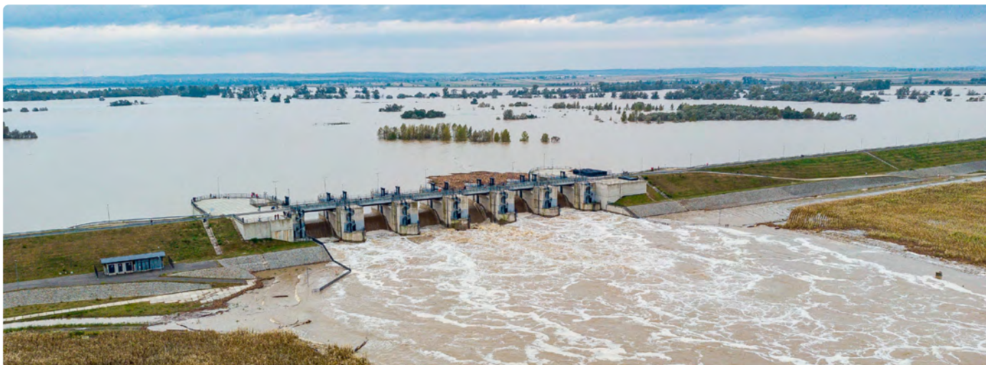
Fot. 11. Suchy zbiornik Racibórz Dolny w trakcie powodzi. Zapora ziemna czołowa wraz z budowlą przelewowo-spustową 17.09.2024r.
