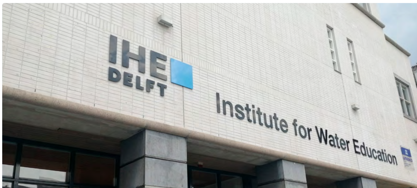
Fot. 13. Budynek Uniwersytetu w Delft
