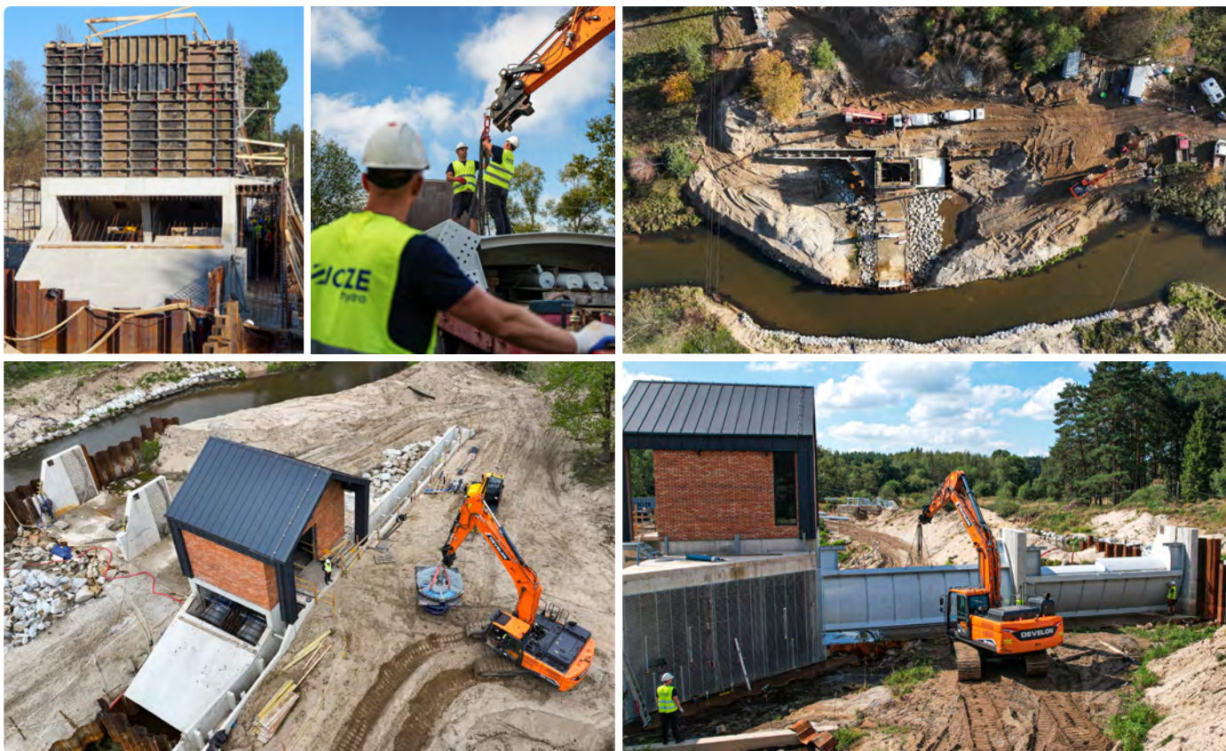
Fot. 8. Prace żelbetowe i montaż elementów wyposażenia elektrowni
