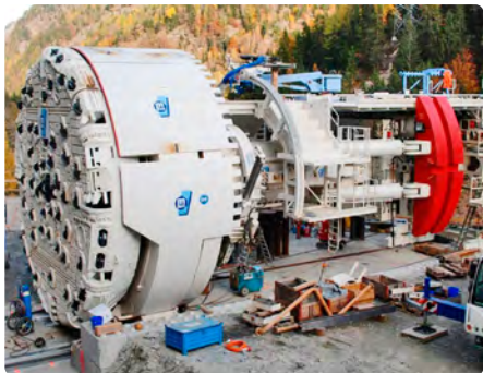
Fot. 3. Montaż głowicy wiertniczej maszyny drążącej w przełęczy w pobliżu miejscowości Châtelard
