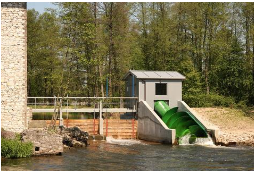
Fot. 1 Śruba Archimedesesa w MEW Bieleckie Młyny Źródło: IOZE hydro
