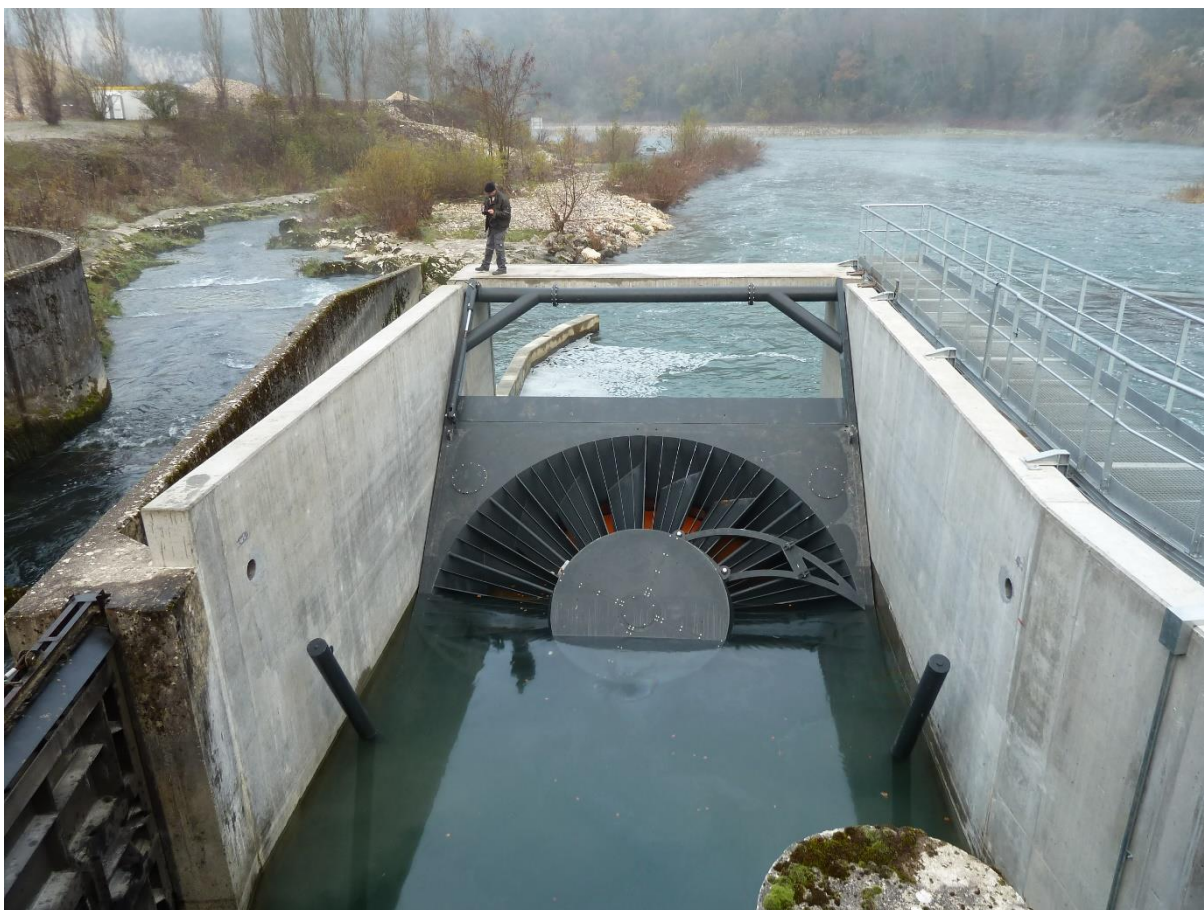
Fot. 2 Turbina VLH Źródło: Archiwum ITE
