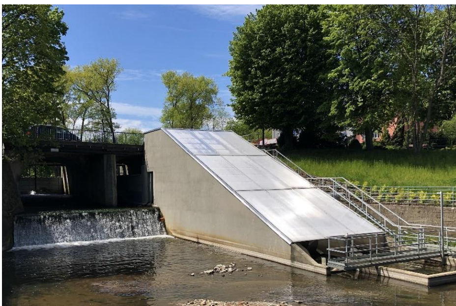
Fot. 8 Aktywna przeławka w Starogardzie Gdańskim na rzece Wierzyca Źródło: IOZE hydro
