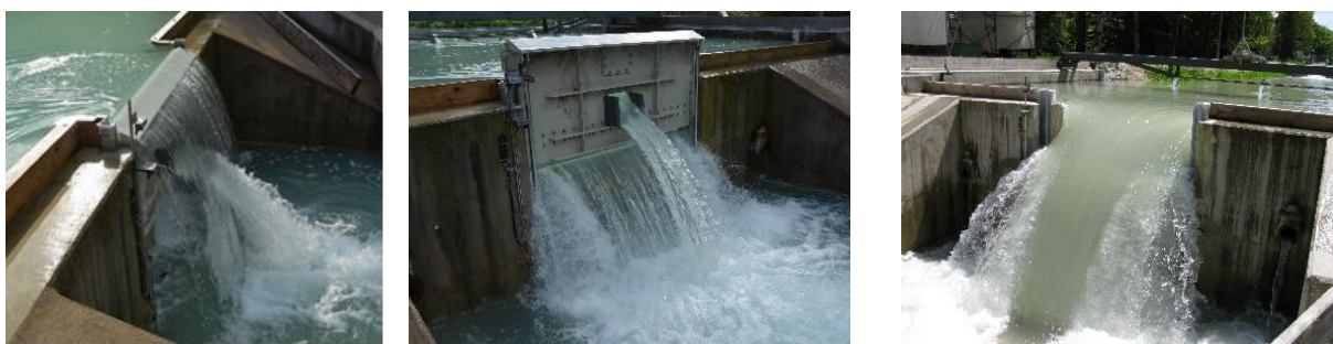
Fot. 4 Różne rodzaje pracy prototypu Hydroshaft (od lewej do prawej): normalny; czyszczenie krat wlotowych; zrzut powodziowy
