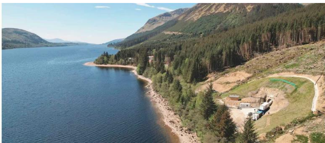
Fot.15 Elektrownia Wodna Coire Glas Źródło: Hydropower Sustainability Alliance
