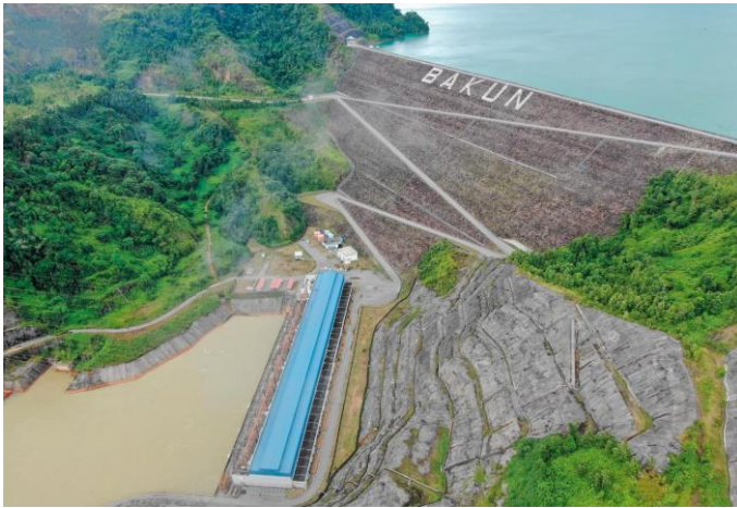
Fot. 13 Elektrownia Wodna Bakun Źródło: Hydropower Sustainability Alliance
