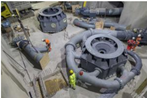
Rysunek 16: Turbina Peltona o mocy 7 MW w elektrowni wodnej Gletsch Oberwald (Szwajcaria) (źródło: FMV SA)
