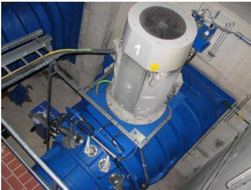
Rysunek 30: Typowy kompaktowy hydrozespół z kątową przekładnią zwiększającą prędkość obrotową. MEW Oborniki, Polska (źródło: archiwum IMP PAN)
