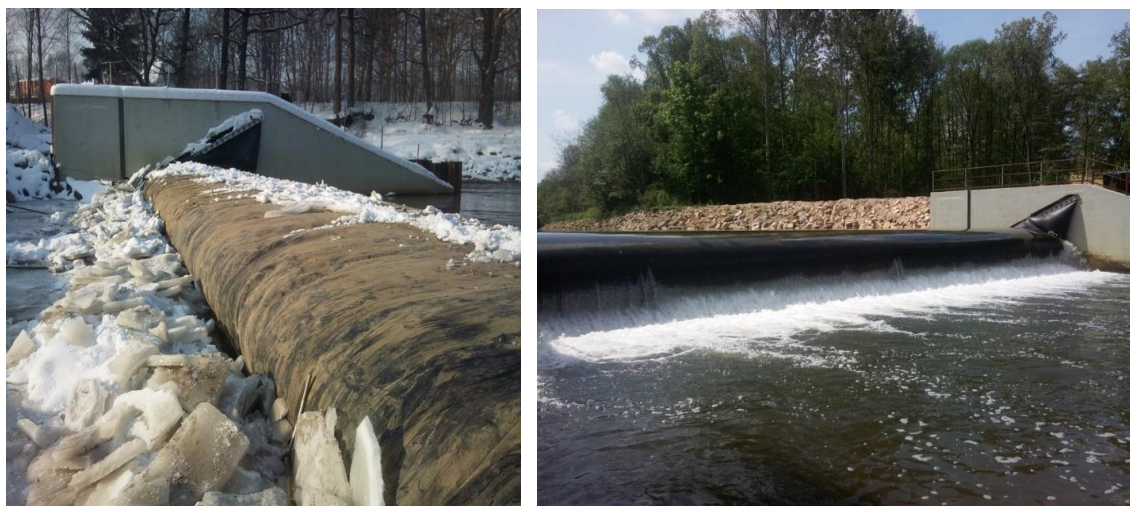
Rysunek 67: Jaz pneumatyczny w okresie zimowym i letnim, Mała Elektrownia Wodna Kliczków na rzece Kwisie, Polska (Polniak, 2015)
